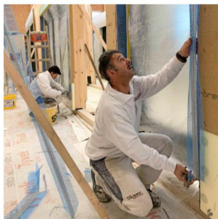
Bevor die Außenwände die Halle verlassen, wird der Putz aufgetragen.
