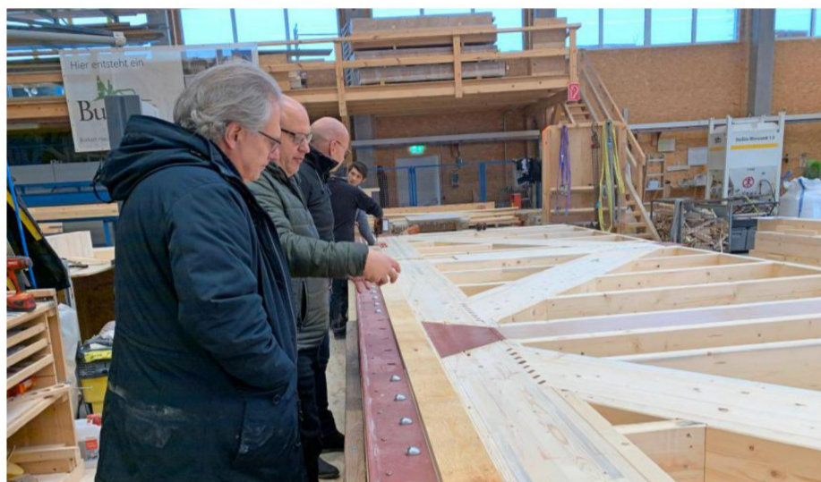
1000 Kubik Holz werden in dem Hochhaus verbaut. An Stellen, an denen eine Last von 180 Tonnen runterkommt, werden schmale Stahlträger verwendet.
